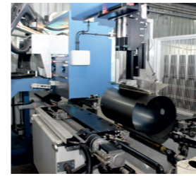
Роботизированное оборудование вальцовки и сварки (Италия, Швеция)
